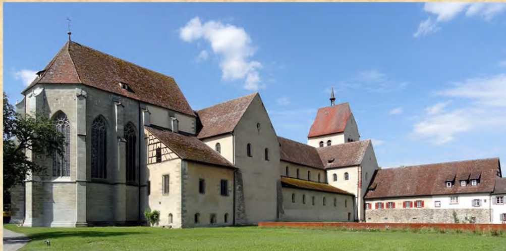
Klosteranlage auf der Insel Reichenau heute
